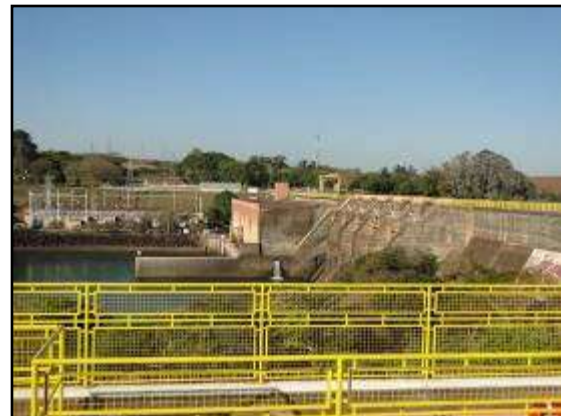
Figura 30 - Vista da hidrelétrica
