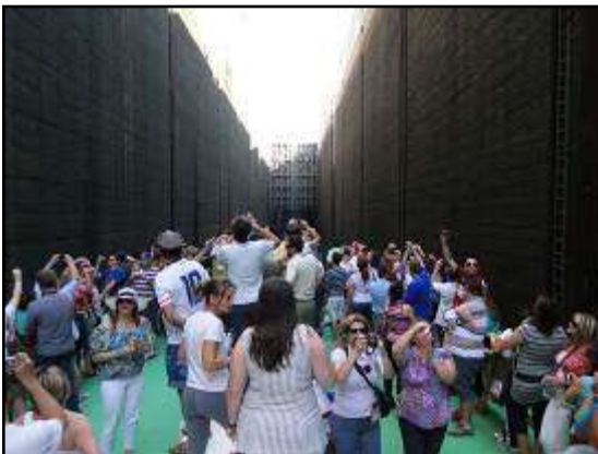
Figura 29 - Passagem pela eclusa
